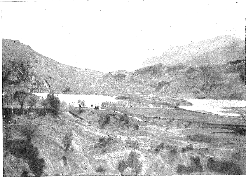
Fot. 11.—La presa y casas del embalse de Santa María de la Peña; ambos estribos apoyan en las calizas eocenas. El vaso, en primer término, en margas eocenas. Al fondo los conglomerados oligocenos de Punta Común, al norte de Murillo de Gállego. (Fotografía orientada al Sur.)
